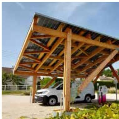
Prévoir un débord de toiture ou réduire l'entraxe des portiques pour créer un débord de toiture (suivant calepinage).
