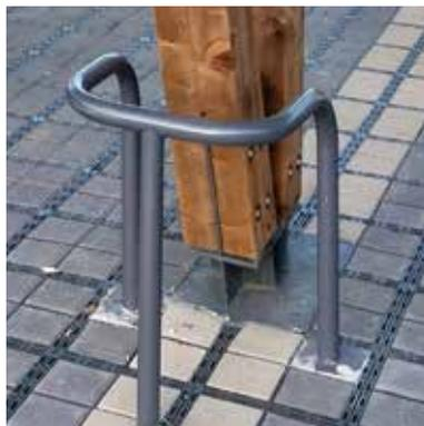
Protéger les poteaux des chocs avec les véhicules par un plot ou un arceau.
